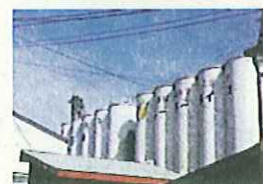
カントリーエレベーター
