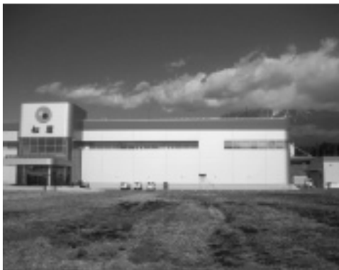
図2 カット野菜工場 (右端の建物が残さ処理場)
