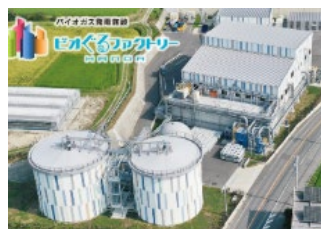
バイオガスプラント
