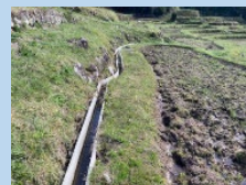
【土水路にU字溝を設置】
